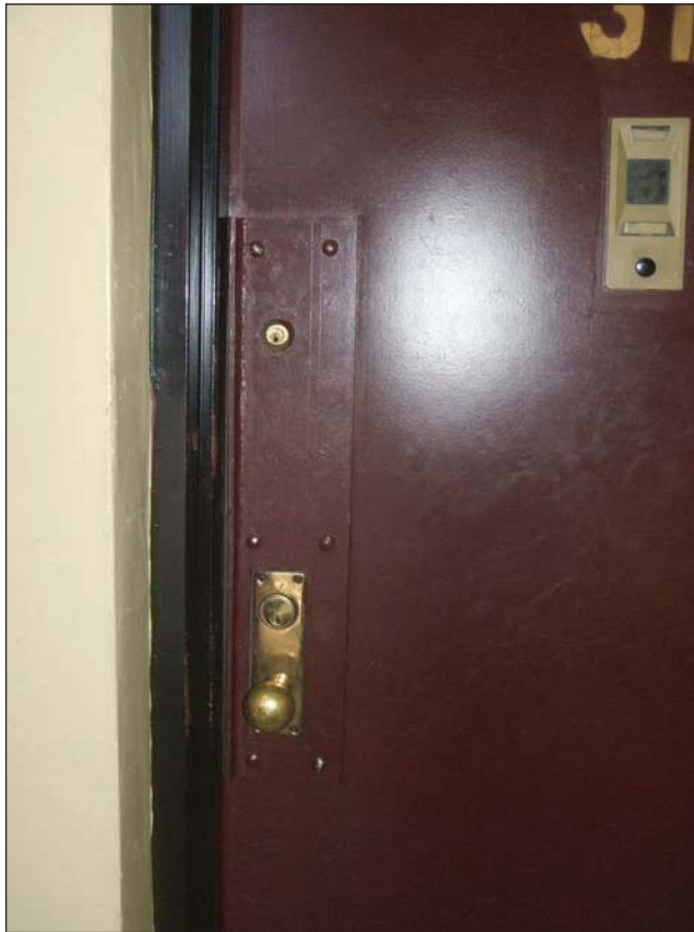
Fig. 12-43. Angle iron on inward-opening door
